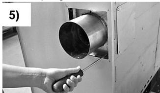
5) Montieren Sie die Gleitrosette mit Hilfe der Schrauben mit denen der Innensicherheitsdeckel befestigt war
