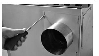
Montieren Sie das Außensicherungsblech mit Hilfe der Schrauben mit denen der Außensicherheitsdeckel befestigt war
