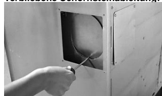
Nehmen Sie das Blech unter dem Innendeckel durch Drücken an der schwächsten Stelle ab
